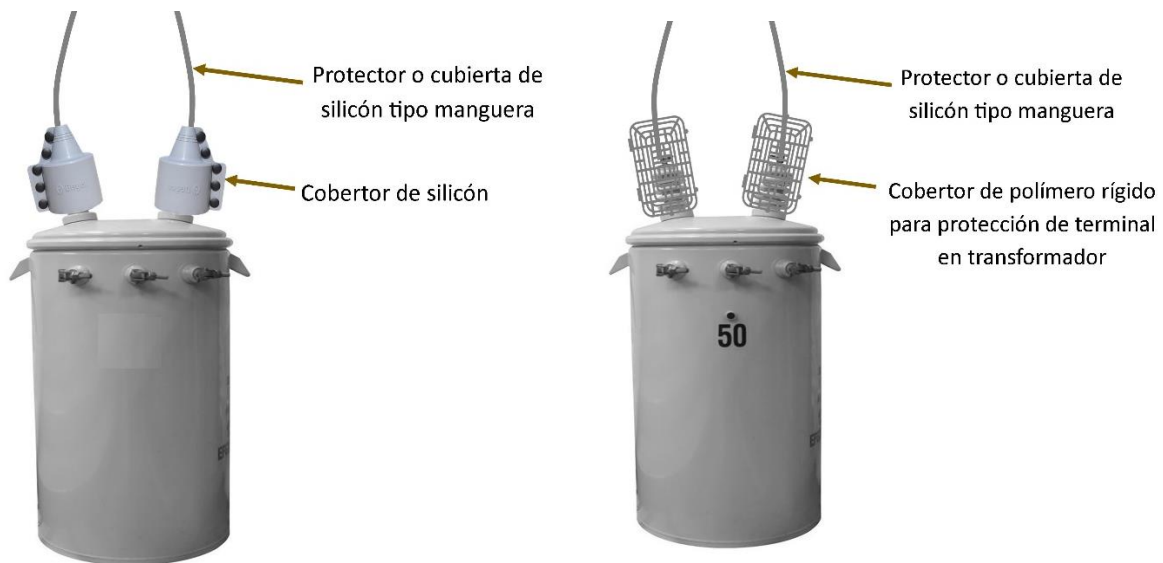
Figura 29 A. Cobertores de goma siliconada y cobertores poliméricos rígidos para aislar los puntos de contacto y partes energizadas.
