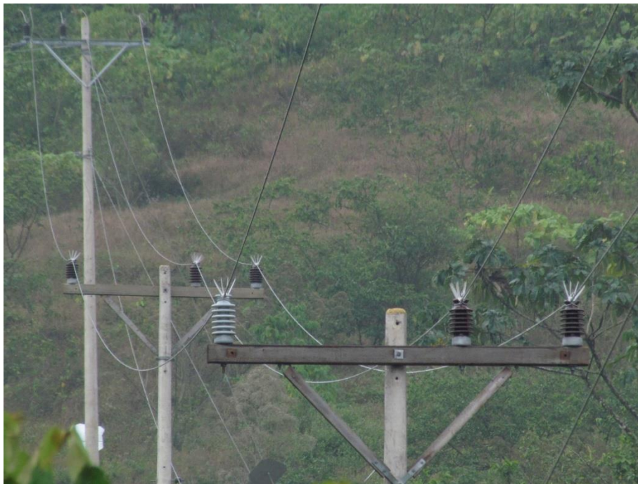
Figura 26. Dispositivo anti-percha tipo pico de paloma, diseño y forma correcta de colocar. (Imágenes fuente CNFL)
